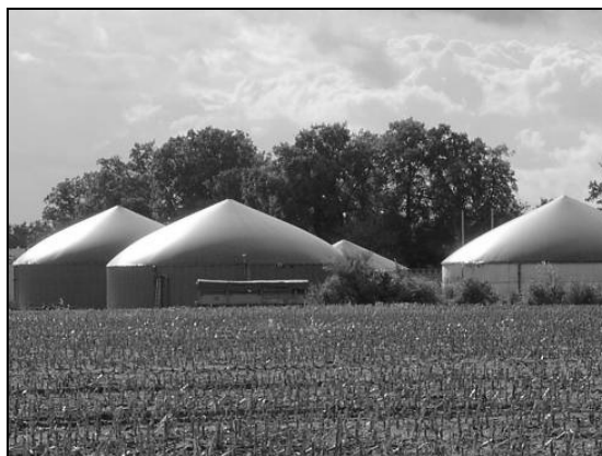
Ilustracja 3-42: Dolna konstrukcja dachu pneumatycznego (z lewej); biogazownia z dachami pneumatycznymi (z prawej); zdjęcia: MT-Energie GmbH
