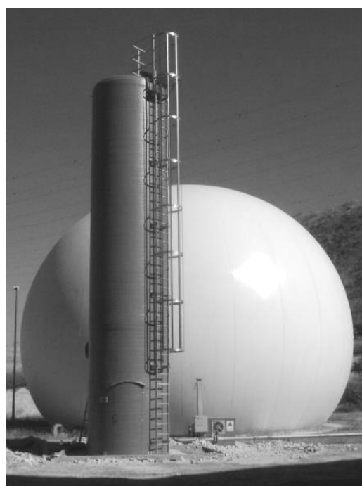
Rysunek 5-2: Zewnętrzne instalacje biologicznego odsiarczania, na prawo obok zbiornika gazu; Zdjęcia: S&H GmbH & Co. Umweltengineering KG
