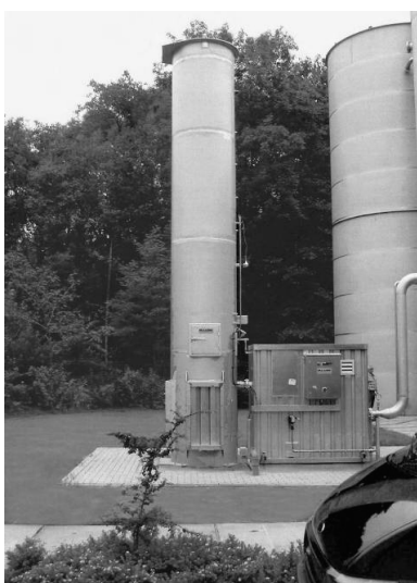
Ilustracja 3-43: Pochodnia awaryjna w biogazowni; zdjęcie: Haase Umwelttechnik AG
