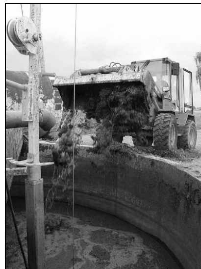
Ilustracja 3-24: Zbiornik wstępny ew. zbiornik przyjmujący podczas załadunku; zdjęcia: Loick Bioenergie, ENR – Energiegesellschaft nachwachsender Rohstoffe mbH; Hugo Vogelsang Maschinenbau GmbH
