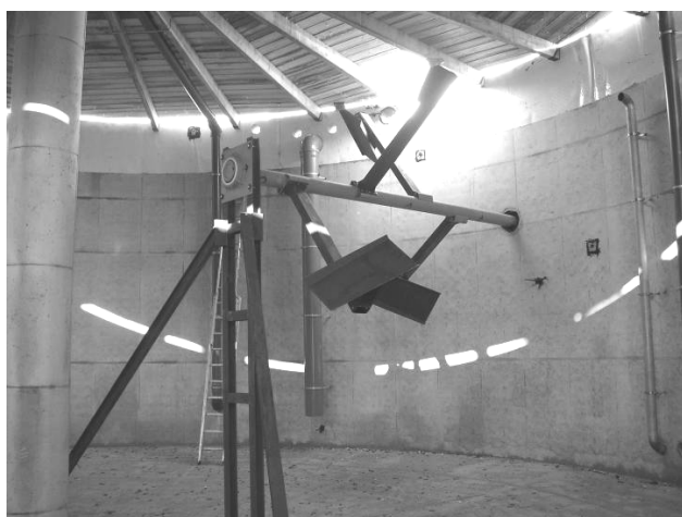
Ilustracja 3-39: Mieszadło łopatkowe; Zdjęcie: PlanET Energietechnik
