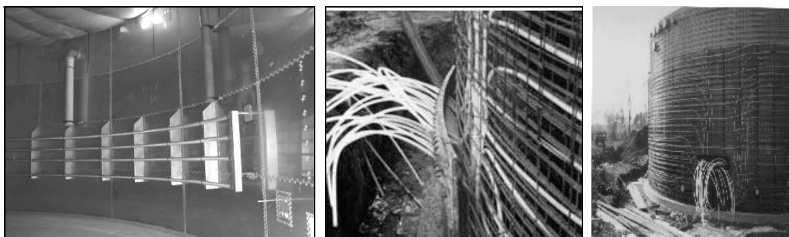
Ilustracja 3-35: Rury grzewcze ze stali szlachetnej ułożone fermentatorze (z lewej); zdjęcie: Anlagen- und Apparatebau Lütke GmbH, zabudowywanie rurowych przewodów grzewczych w ścianie fermentera (z prawej); zdjęcia z lewej i prawej: Biogas Nord GmbH; zdjęcie z prawej: PlanET Energietechnik
