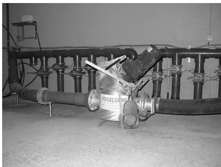
Ilustracja 3-18: Rozdrabnianie substratu w przewodzie tłoczącym; zdjęcia: Hugo Vogelsang Maschinenbau GmbH
