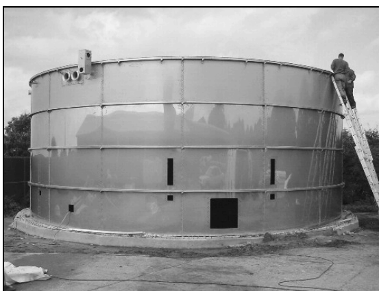
Ilustracja 3-34: Fermentatory ze stali szlachetnej w stadium budowy; zdjęcie: Anlagen- i Apparatebau Lütke GmbH
