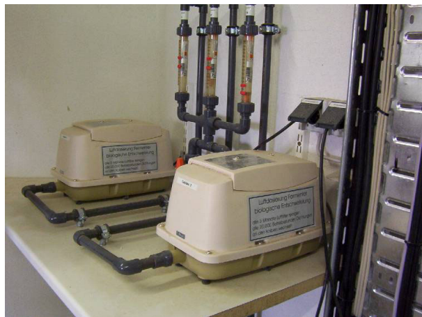
Rysunek 5-1: Regulacja gazu dla dmuchawy powietrza do przestrzeni fermentatora na gromadzenie się gazu; zdjęcie: Institut für Energetik und Umwelt gGmbH
