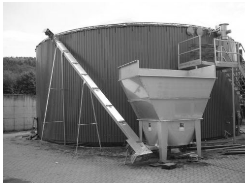
Ilustracja 3-27: Wprowadzanie biomasy składowanej luzem za pomocą przenośników ślimakowych; zdjęcie: Pumpe GmbH
