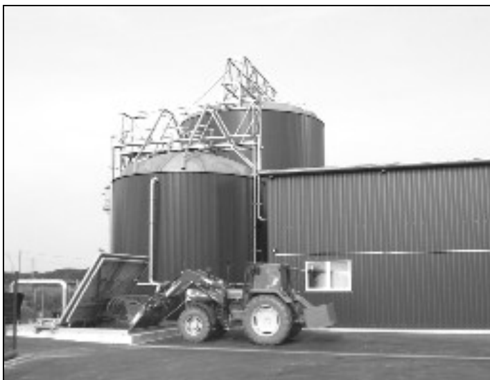
Ilustracja 3-24: Zbiornik wstępny ew. zbiornik przyjmujący podczas załadunku; zdjęcia: Loick Bioenergie, ENR – Energiegesellschaft nachwachsender Rohstoffe mbH; Hugo Vogelsang Maschinenbau GmbH
