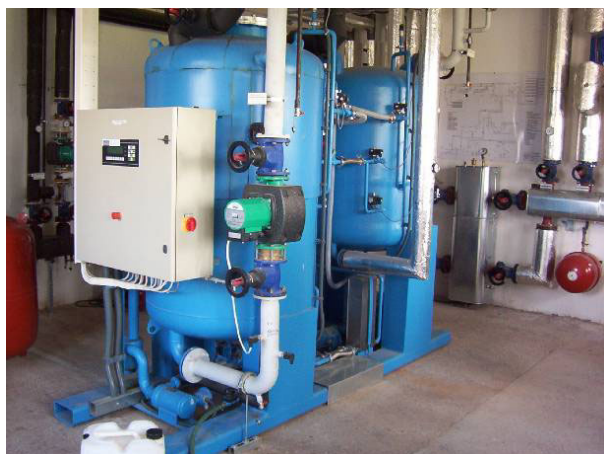
Rysunek 5-15: Przykład chłodziarki absorpcyjnej zamontowanej w instalacji biogazu; Zdjęcie: Institut für Energetik und Umwelt gGmbH
