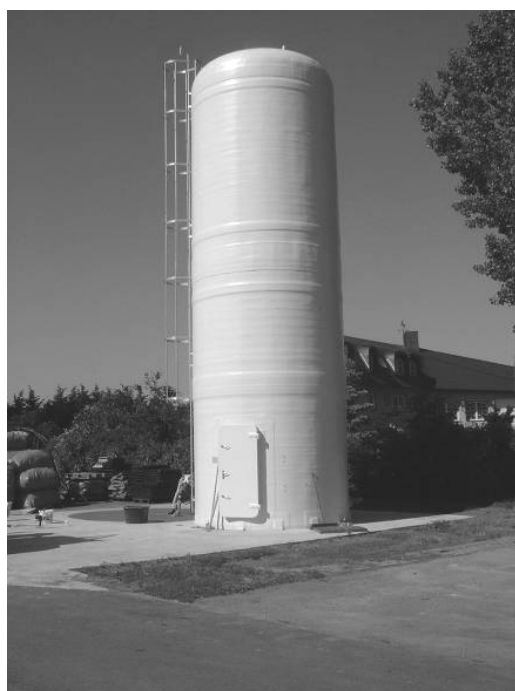
Rysunek 5-2: Zewnętrzne instalacje biologicznego odsiarczania, na prawo obok zbiornika gazu; Zdjęcia: S&H GmbH & Co. Umweltengineering KG
