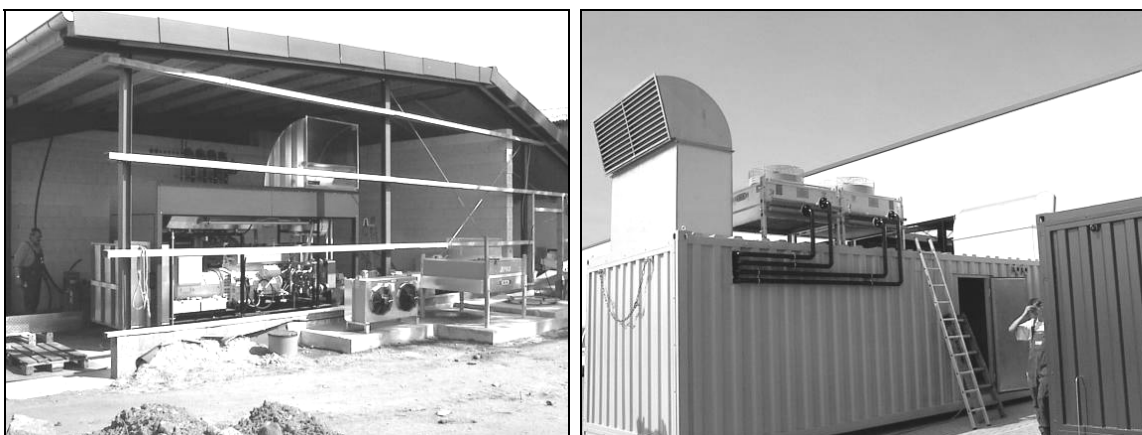
Rysunek 5-8: Kontener elektrociepłowni blokowej wzgl. montaż elektrociepłowni w budynku; Zdjęcia: Seva Energie AG
